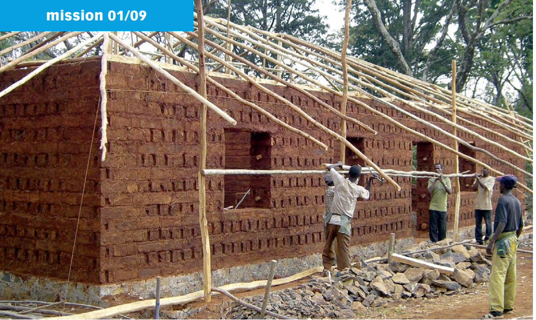
Die neue Bibliothek der Mittelschule im Rohbau.
