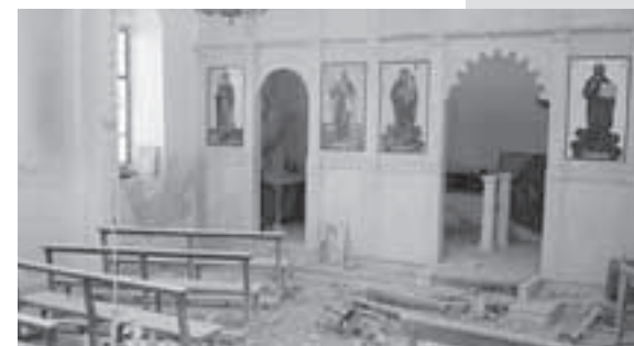
Eine zerstörte Kirche im Südlibanon.
